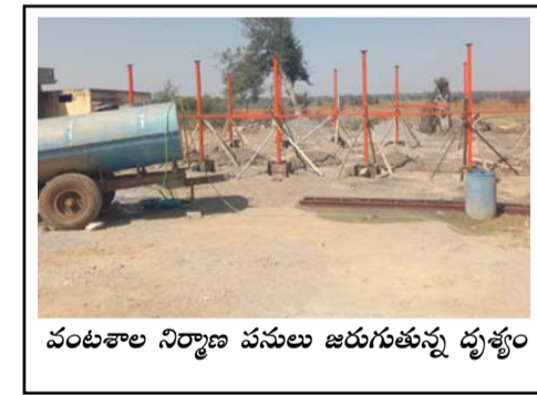
వంటశాల నిర్మాణ పనులు జరుగుతున్న దృశ్యం
