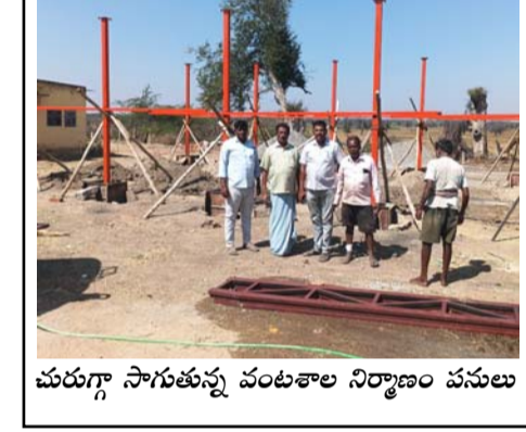
చురుగ్గా సాగుతున్న వంటశాల నిర్మాణం పనులు
