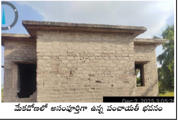
మేకడోణలో అసంపూర్తిగా ఉన్న పంచాయతీ భవనం
