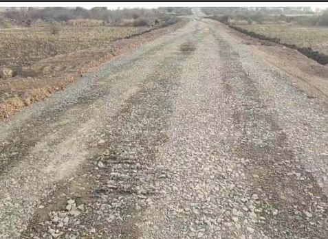
తారు రోడ్డు నిర్మాణ పనులు చేస్తున్న దృశ్యం
