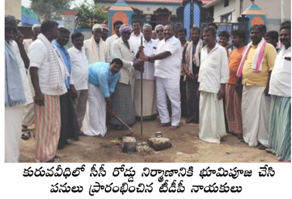
కురువవీధిలో సీసీ రోడ్డు నిర్మాణానికి భూమిపూజ చేసి పనులు ప్రారంభించిన డి.డి.పి నాయకులు
