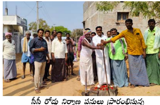
సీసీ రోడ్డు నిర్మాణ పనులు ప్రారంభిస్తున్న టిడిపి నాయకులు బీపీ ఈరన్న
