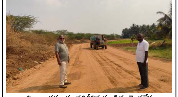
నిర్మాణ పనులను పరిశీలిస్తున్న డి ఈ వెంకటేశ్వర్లు
