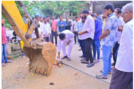
పటేల్ గూడలో సిసి రోడ్డు నిర్మాణ పనులకు
